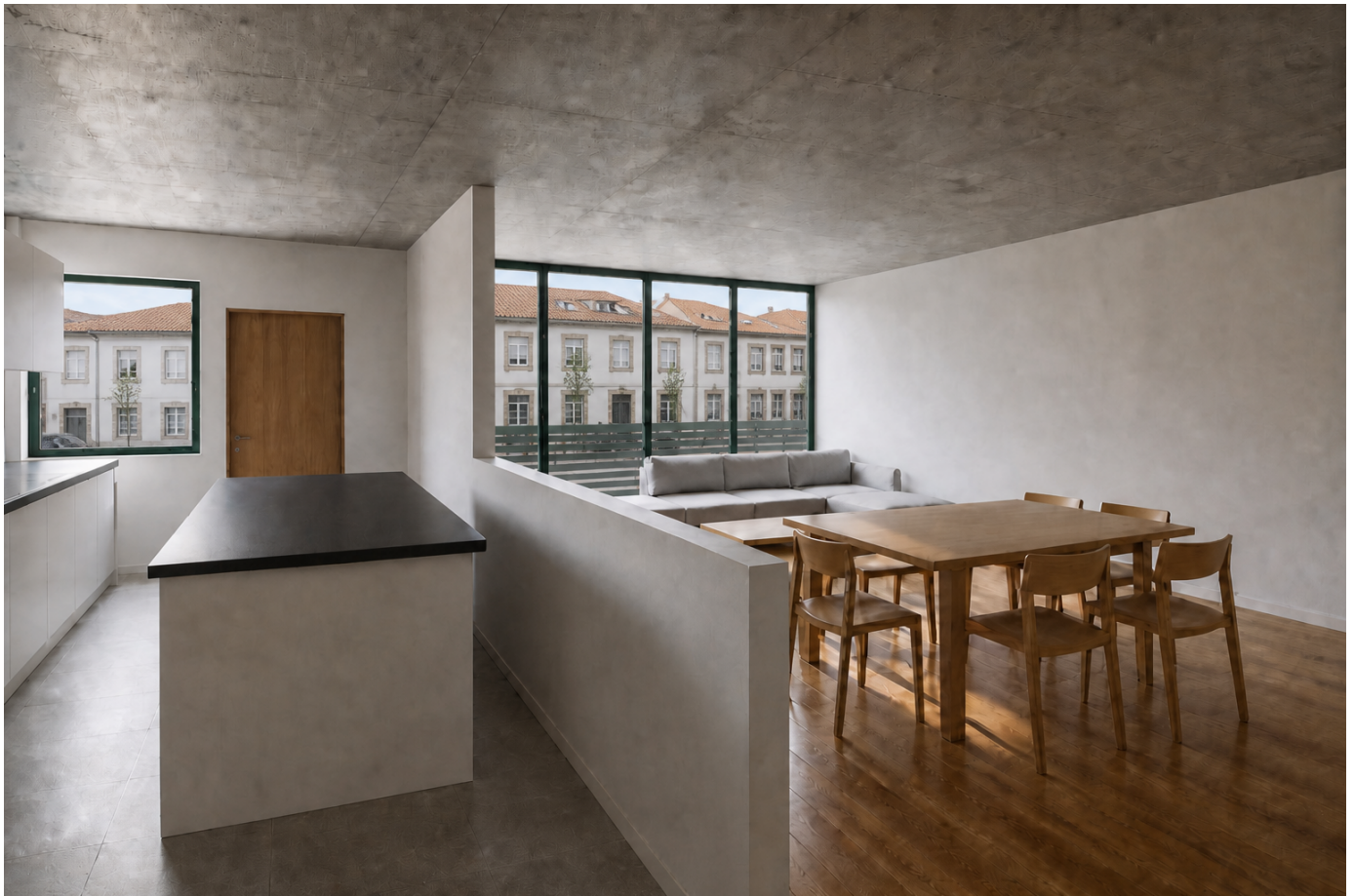
01 sala e cozinha — betão aparente no teto, madeira e mosaico no pavimento, caixilhos em alumínio verde
